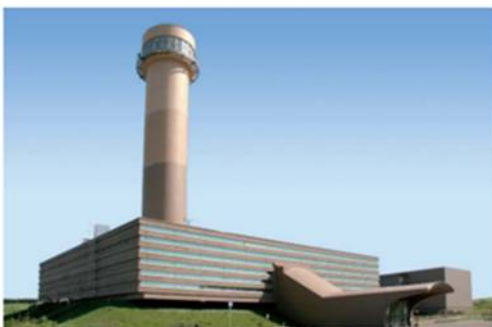
（「ゆめ地創館」平成19年6月30日開館）
