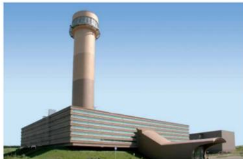
「ゆめ地創館」平成19年6月30日開館
