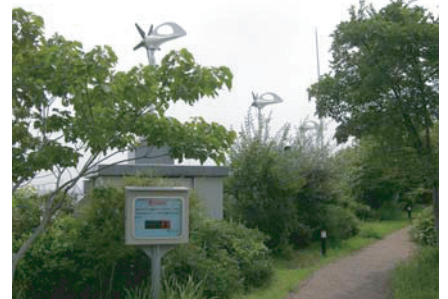
屋上の庭園と風力発電
