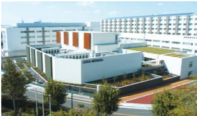
i-ROCK 重粒子線治療施設外観
