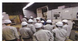
1号機 海水熱交換器建屋
