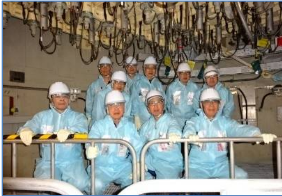
4号機原子炉格納容器（ペDESTアル）の原子炉下部
