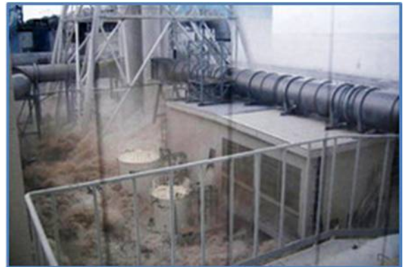
高さ5.5mの重油タンクが水没し始める インターネット抜粋
