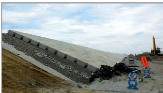
港の防波堤工事中
