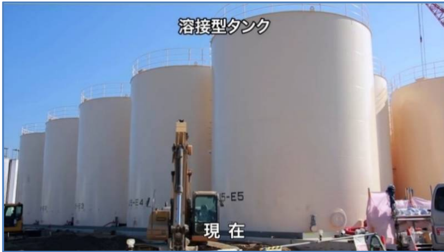
溶接型巨大タンクが並ぶ インターネット抜粋
