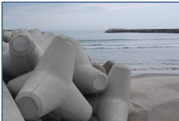
富岡港は改修工事が行われている。隣は砂浜
