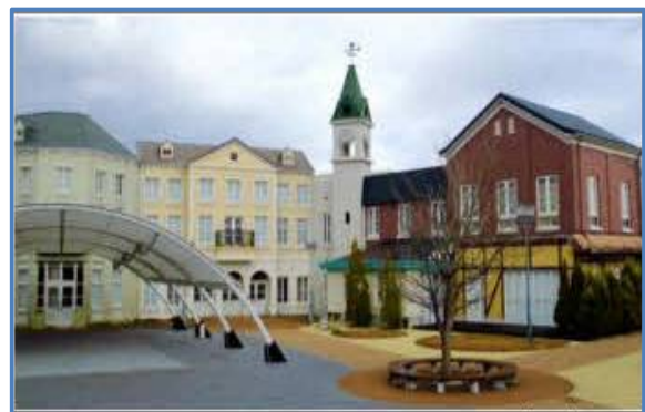
廃炉資料館として開館される予定の 旧エネルギー館
