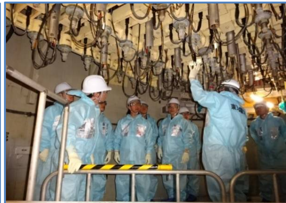
4号機原子炉格納器（ペDESTAL）の原子炉下部
