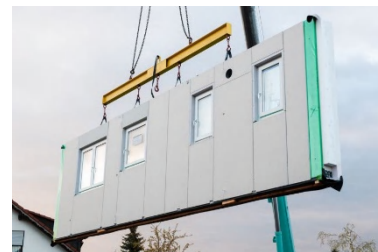
規格化された部材一式を工場生産し作った組み立てユニットを、現地で積み立てるように設置するプレハブ住宅（イメージ）
